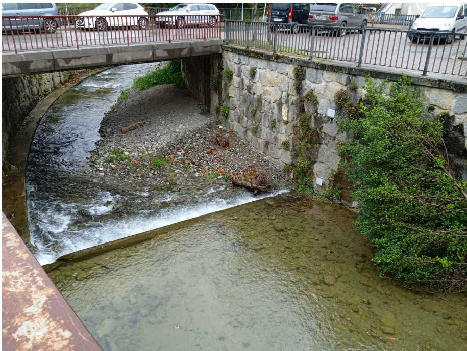
Foto b: Vista de los muros de encauzamiento existentes aguas abajo del azud Biblioteca Alegia (AORIAME000630000). Además, se aprecia el puente existente
