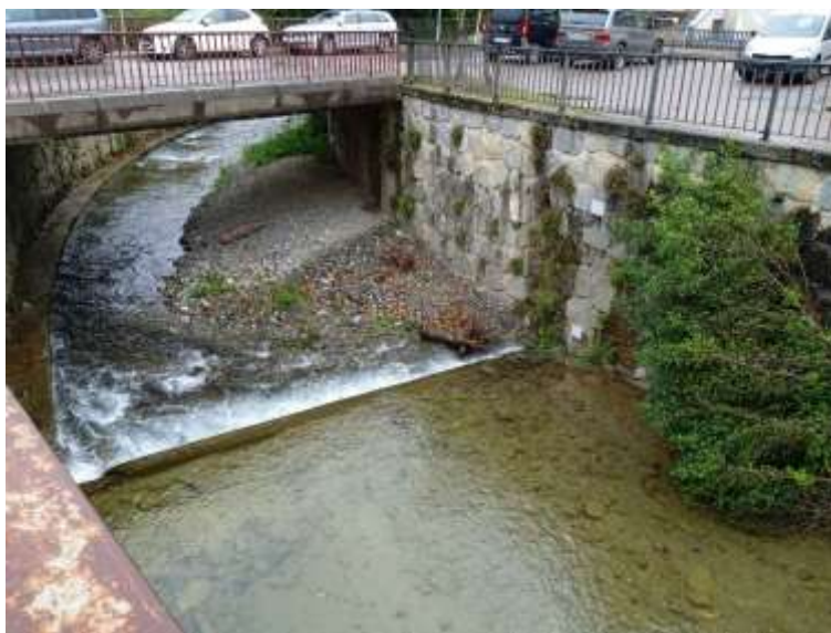
Imagen 1. Detalle de la acumulación de sedimento entre el azud y el puente de acceso a biblioteca.
