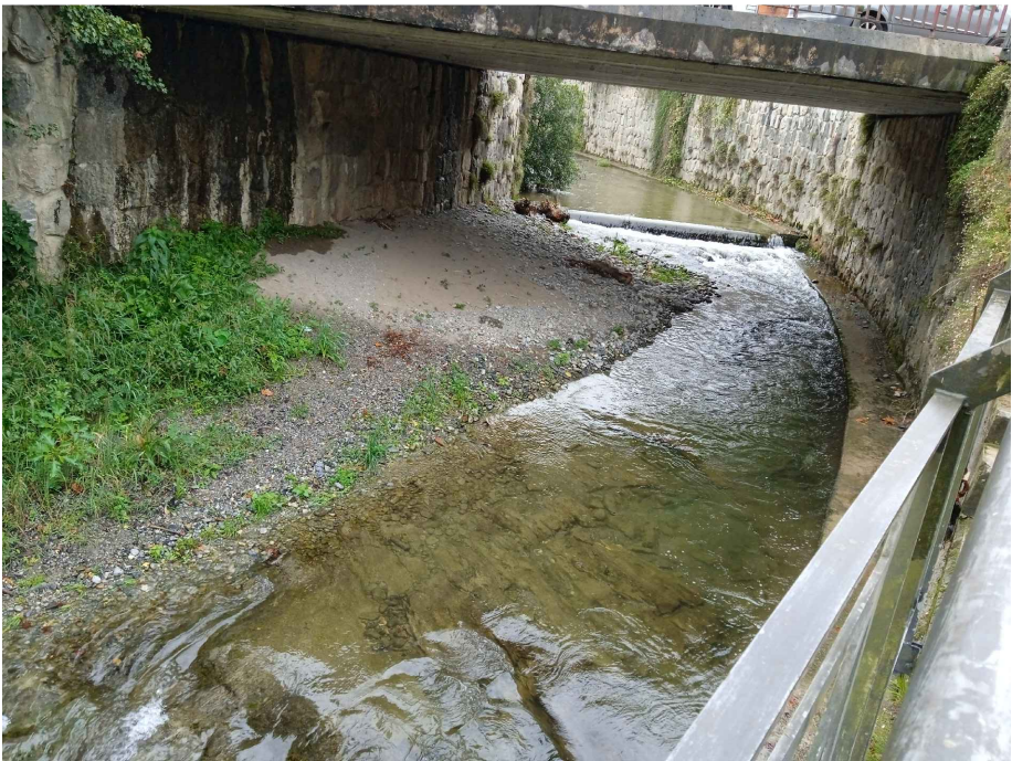
Foto f: Acumulación de sedimento bajo el puente existente aguas abajo del azud. En el lecho del cauce del río se aprecia el sustrato rocoso
