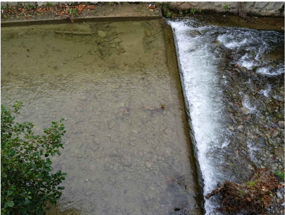
Foto c: Detalle del estado de colmatación del trasdós del azud Biblioteca Alegia (AORIAME000630000)
